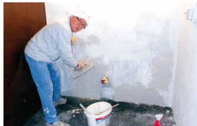
Stephan Henz beim Verputzen der alten Wände ▲
