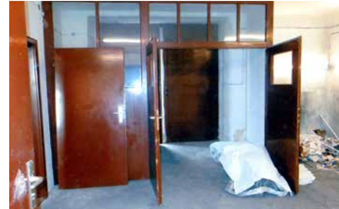
Der Eingangsbereich bei der Renovierung ▲
